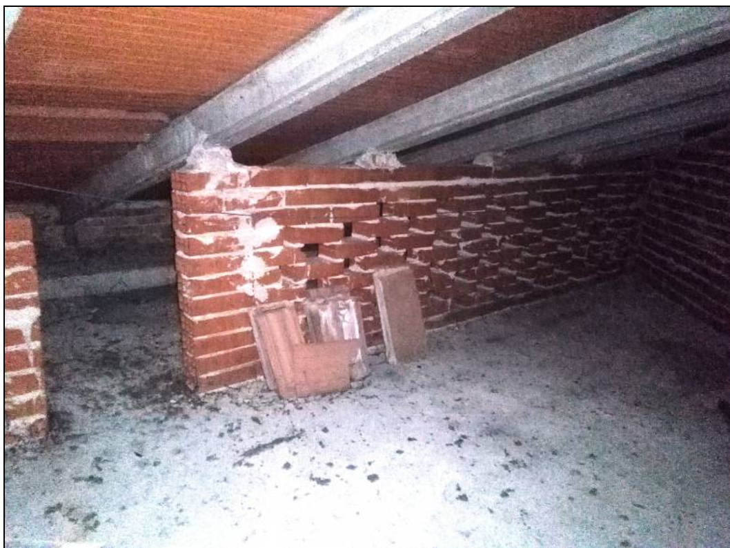
Vista del solaio sottotetto e copertura
