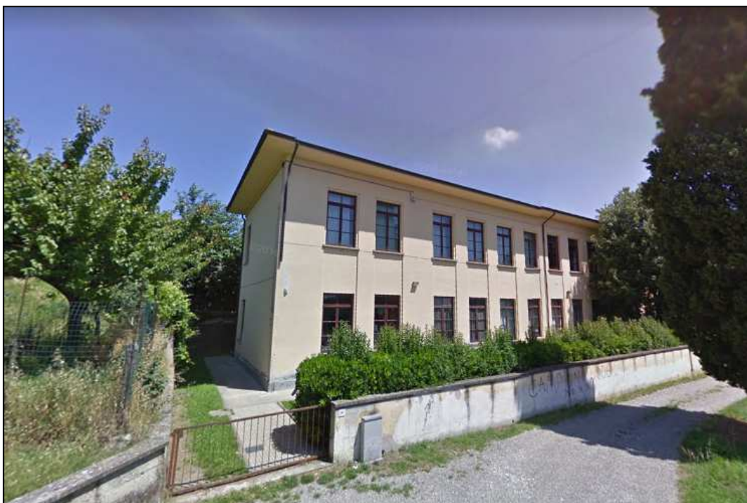
Vista prospetto tergale dell'edificio in oggetto
