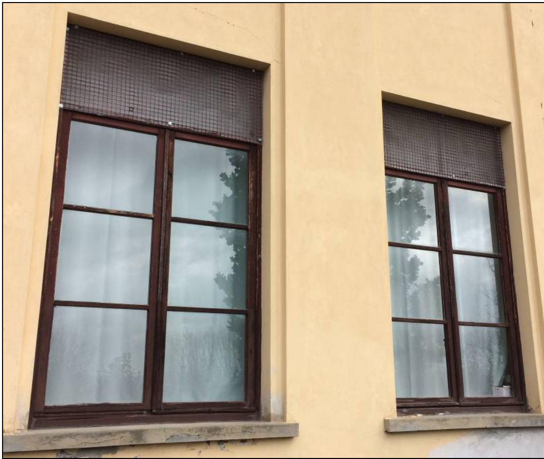
Vista delle finestre dell'edificio
