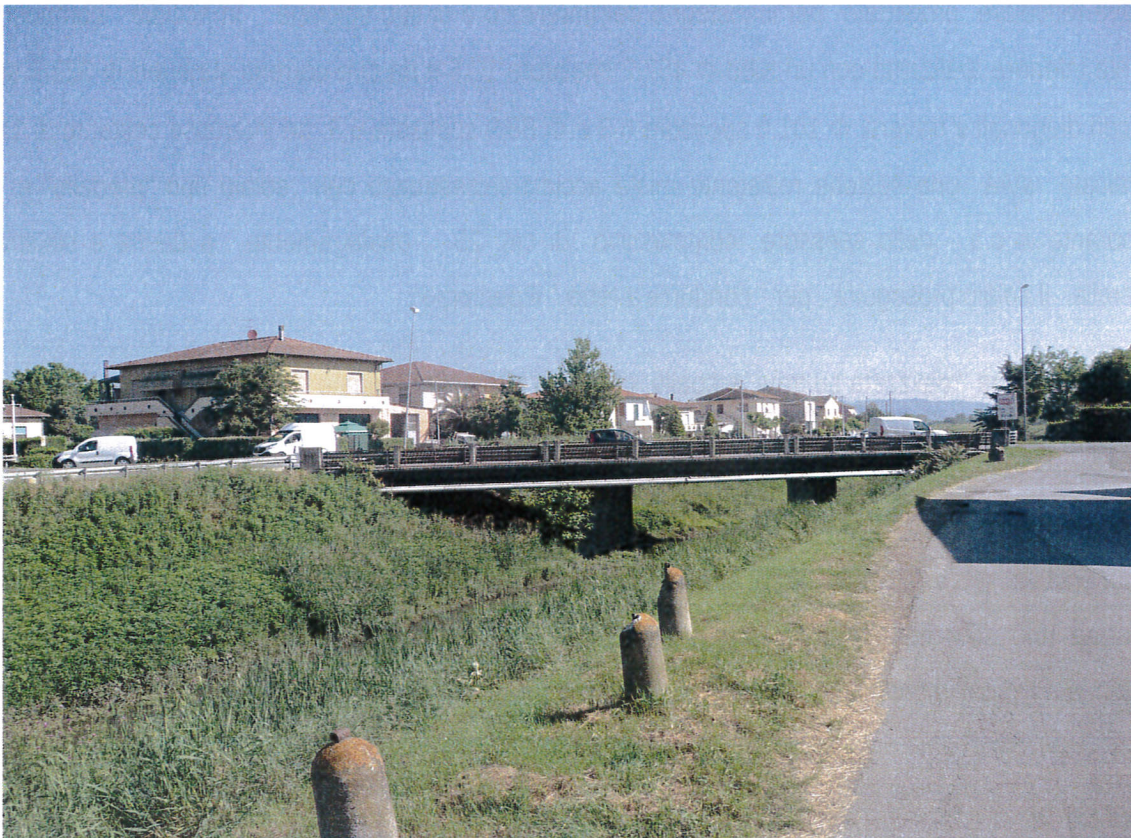
Foto del collettore nel punto di attraversamento dell'opera in progetto
