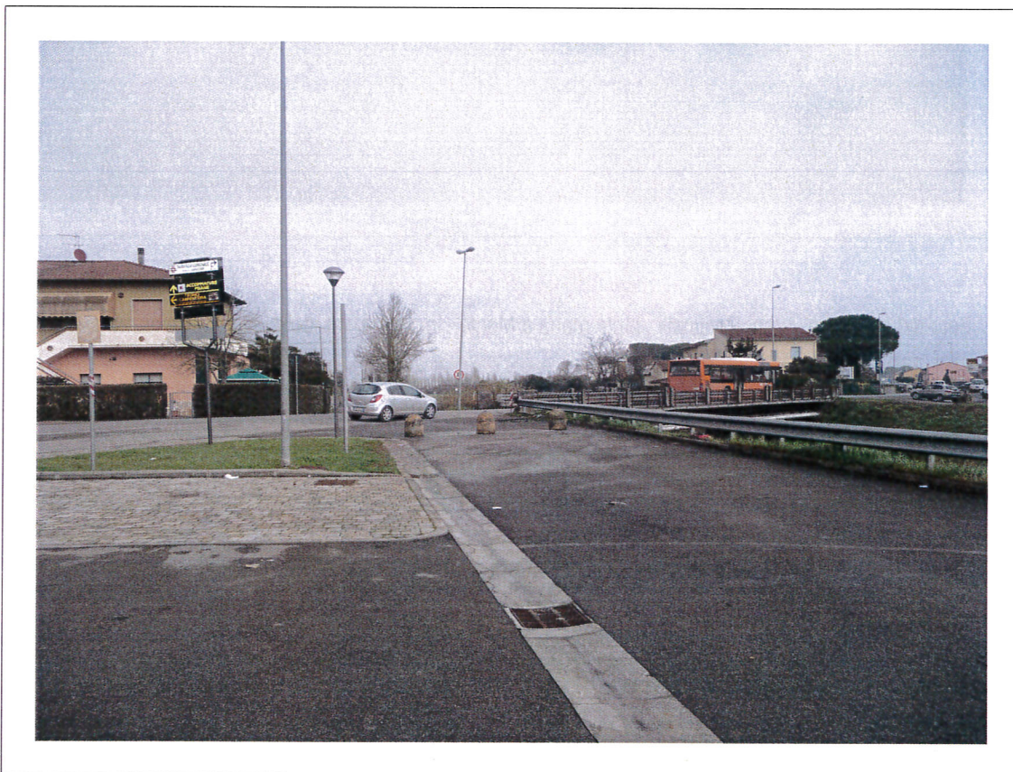
Foto del collettore verso Castelfranco di Sotto , in prossimità del quale sarà realizzata l'opera
