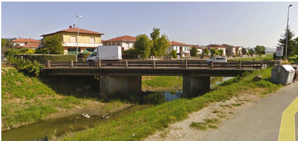
Figura 10: Ponte carrabile esistente visto da valle verso monte
