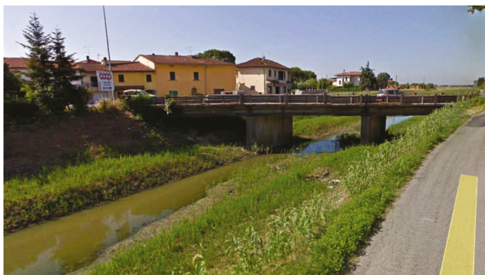
Figura 11: Ponte carrabile esistente visto da monte verso valle
