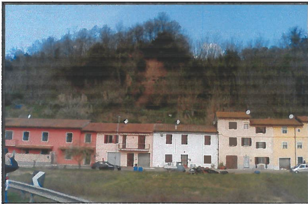
Foto n° 1 – panoramica del versante interessato dal dissesto
