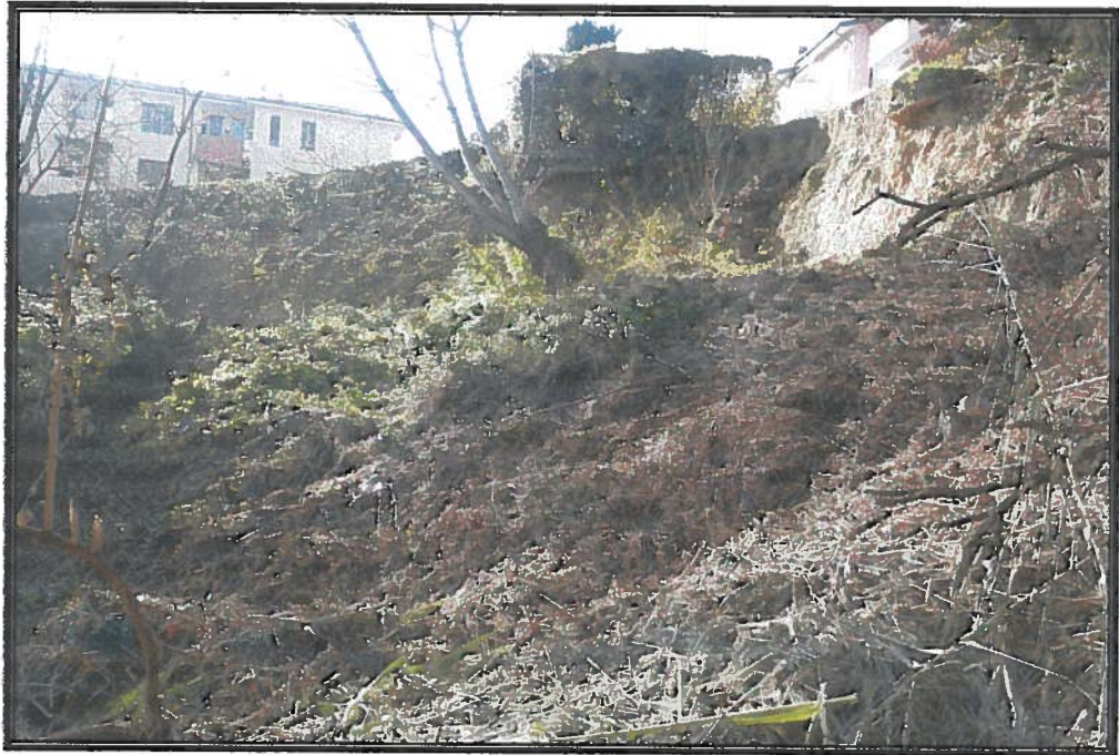
Foto n° 3 --scarpata e corpo di frana
