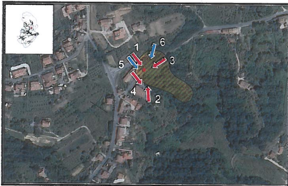
fig. 1 – Ortofoto (2010) con punti di scatto documentazione fotografica Dissesto Via Pregiuntino
