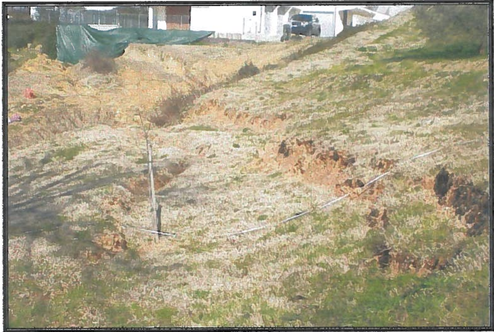
Foto n° 1 4 – particolare del coronamento di frana
