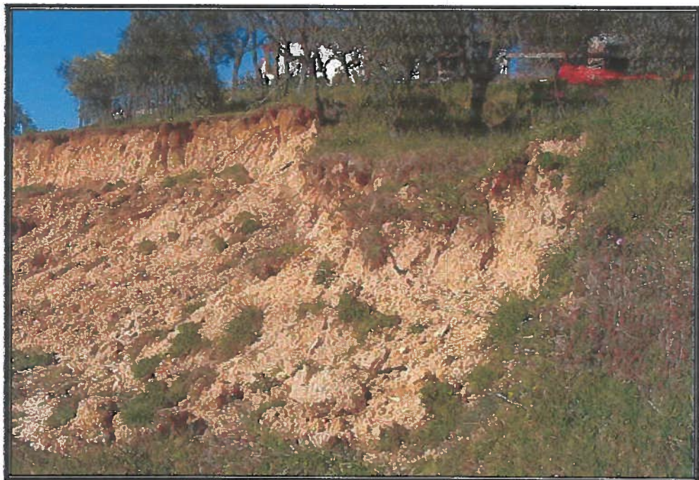
Foto n° 2 - scarpata principale e corpo di frana
