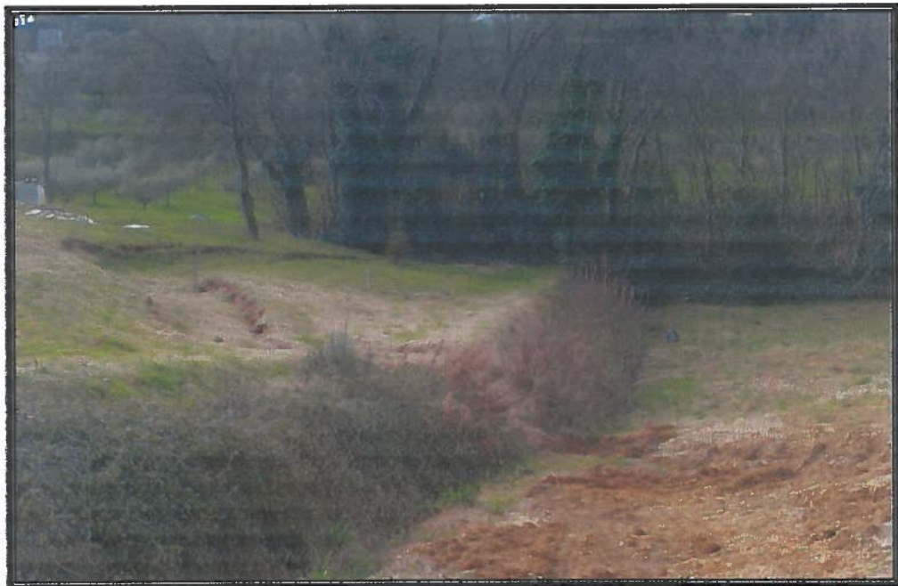
Foto n° 2 5 – panoramica dell'area in frana
