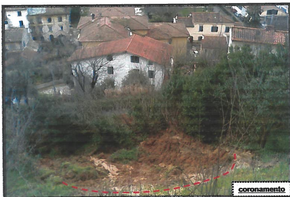
Foto n° 3 – coronamento di frana
