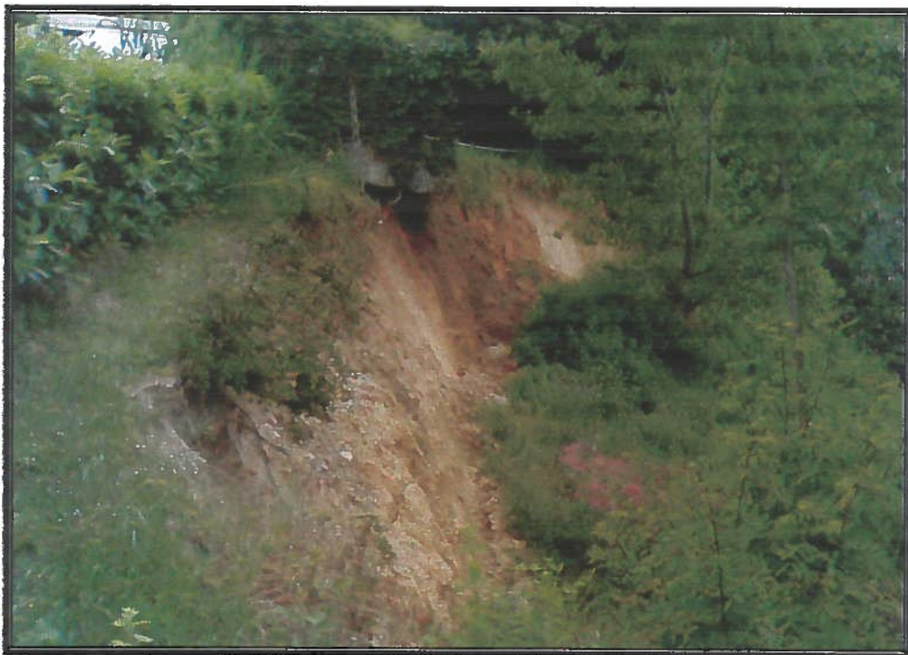
Foto n° 2 – coronamento e scarpata del movimento franoso
