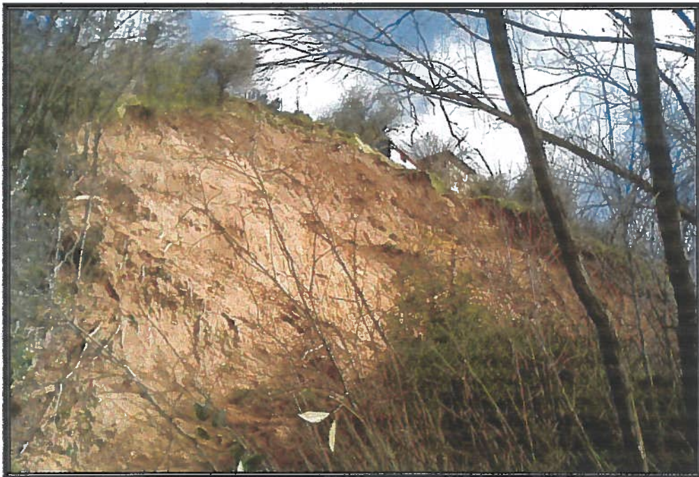
Foto n° 2 – coronamento e scarpata del movimento franoso
