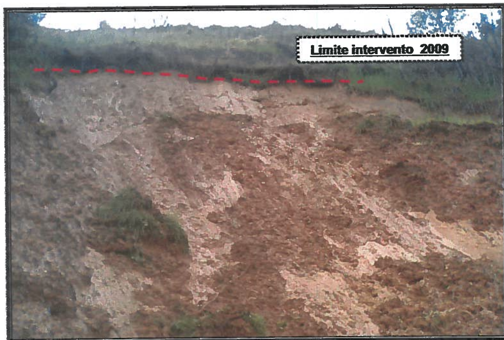
Foto n° 4 – scarpata e corpo di frana
