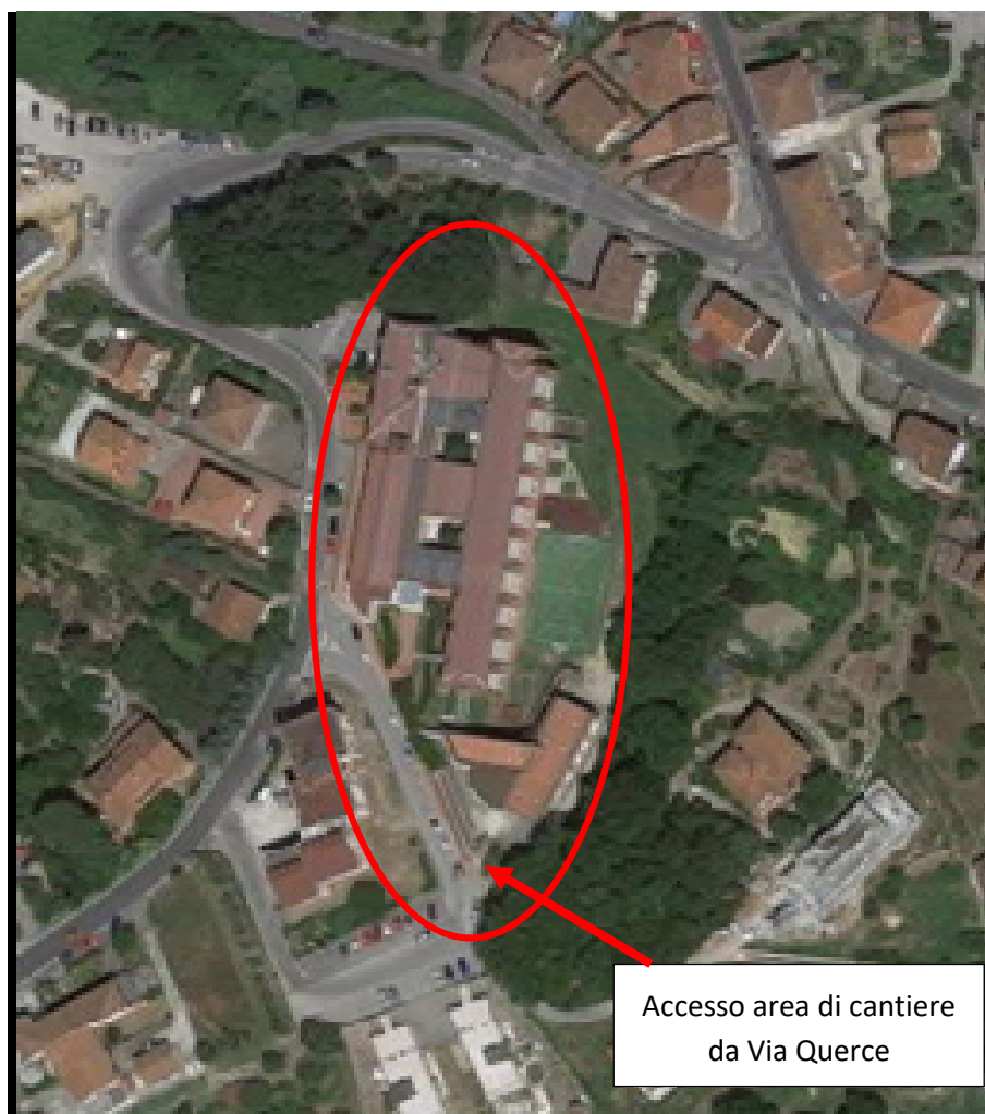
Vista aerea dell'area di intervento
