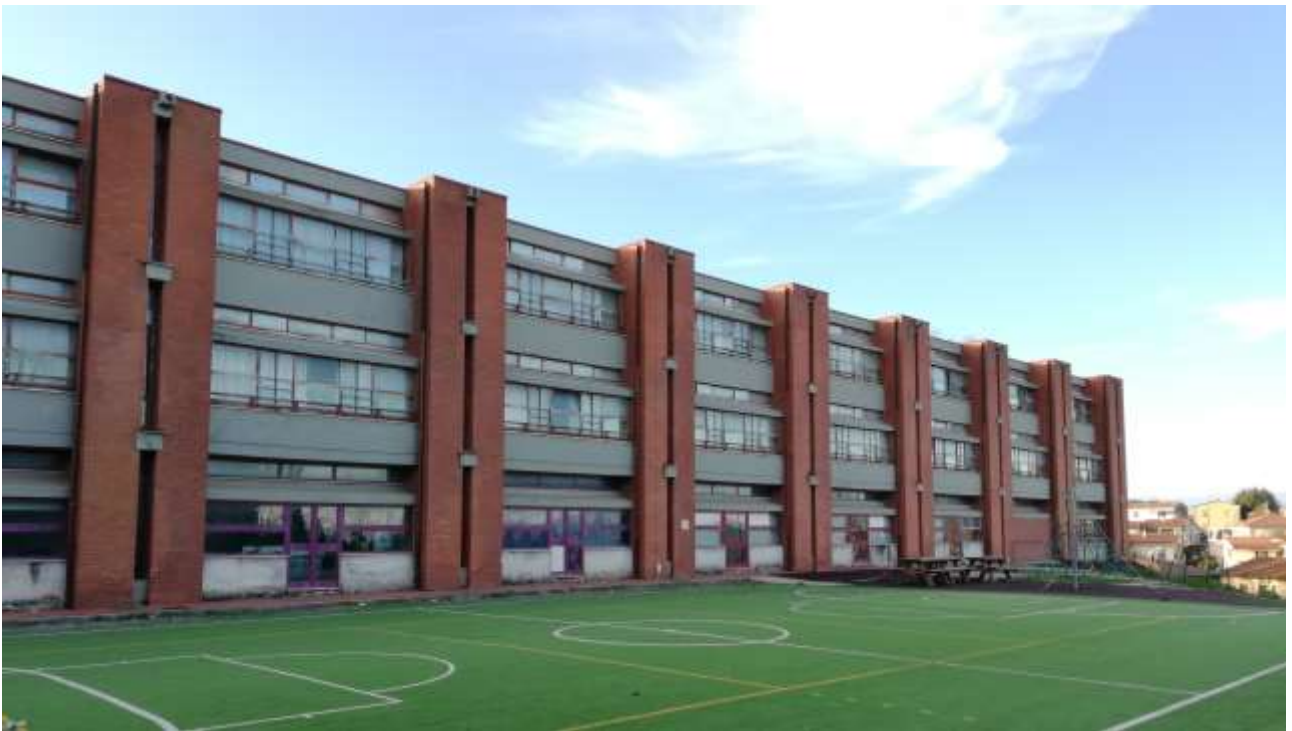
Vista del prospetto posteriore all'edificio
