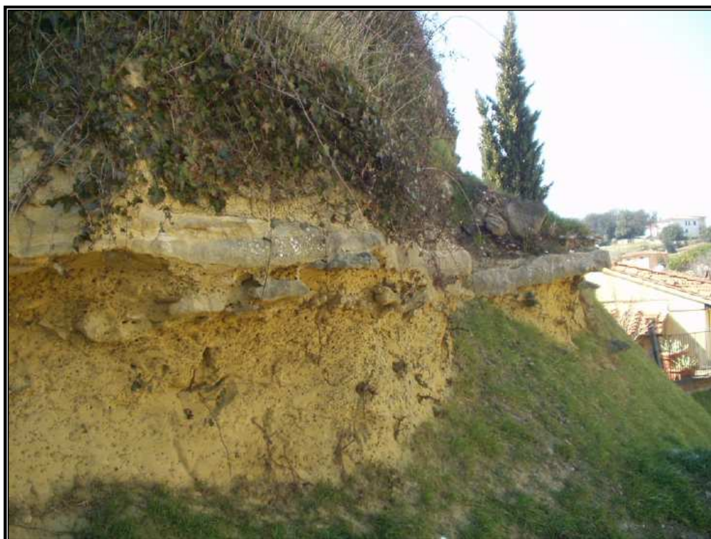
Foto 4 6 Livello di arenarie in precedenza visibile in corrispondenza della cisterna medioevale. Si noti l'effetto mensola del livello arenario, per degradazione dei sottostanti terreni, e l'attività biologica all'interno di quest'ultimi.
