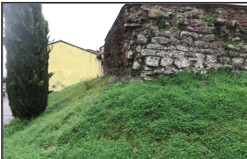
Foto 5 Come si presenta oggi (gennaio 2022) l'area della cisterna.
