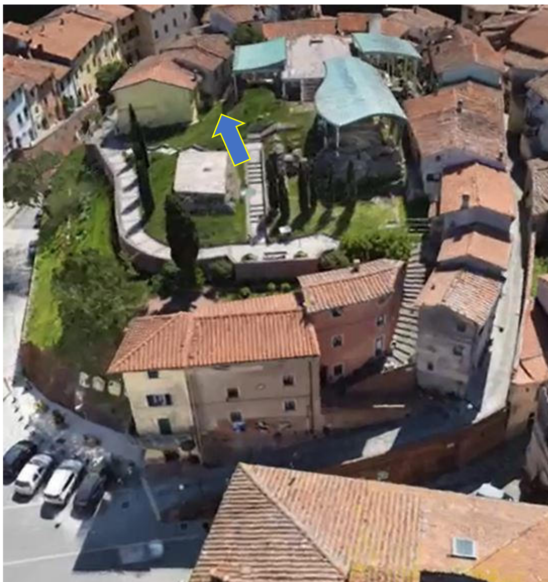
Figura 1 – Luogo dove sorgerà la passerella
