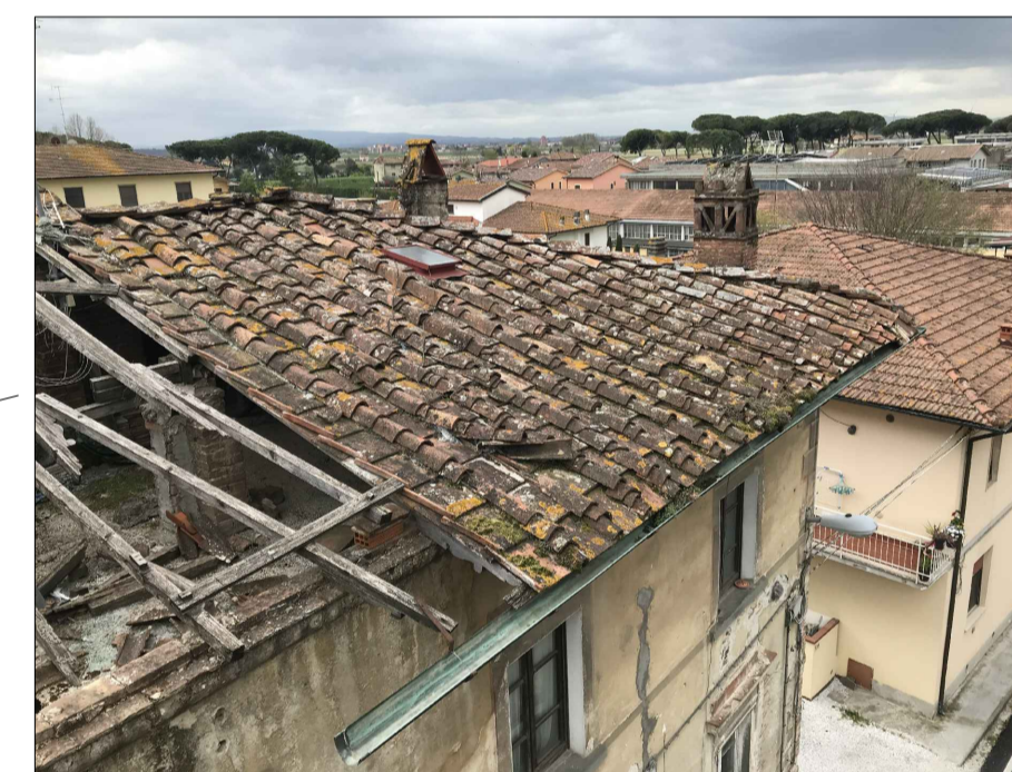
Solaio di copertura
