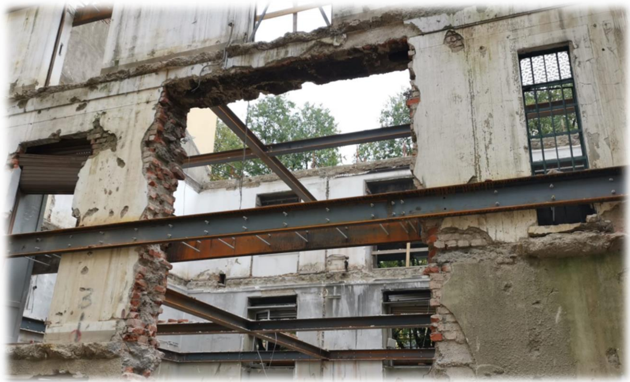
Figura 7 - Esempio applicativo dispositivo anti ribaltamento di facciata
