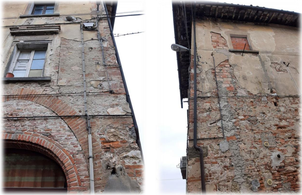
Figura 8 -spinta a vuoto dell'arco e lesione cantonale
